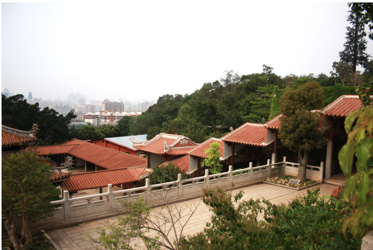
Fot.6. Odbudowane obiekty zespołu klasztornego dawnego Dacheng sy/Bailian sy i zwanego obecnie Chan Shaolin sy
