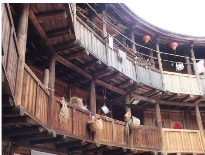
Fot.22.-23 U góry, zewnętrzny mur obronny z wysoko usytuowanymi niewielkimi oknami zewnętrznymi, Poniżej, Każdy pojedynczy wewnętrzny balkon piętra tulou do kwatery jednej rodziny
